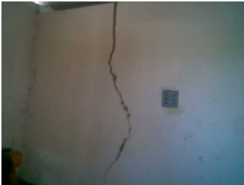
Estado de la estación de bombeo.
